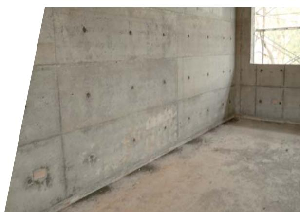
「系統模板免泥作工法」面漏漿少，拆模後混凝土面品質良好，水密性及防水性佳
