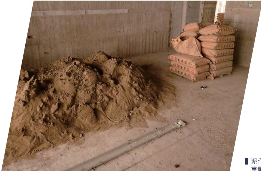
泥作打底工程經核算，其增加的水泥砂漿打底重量約佔結構重量的7%-9%
