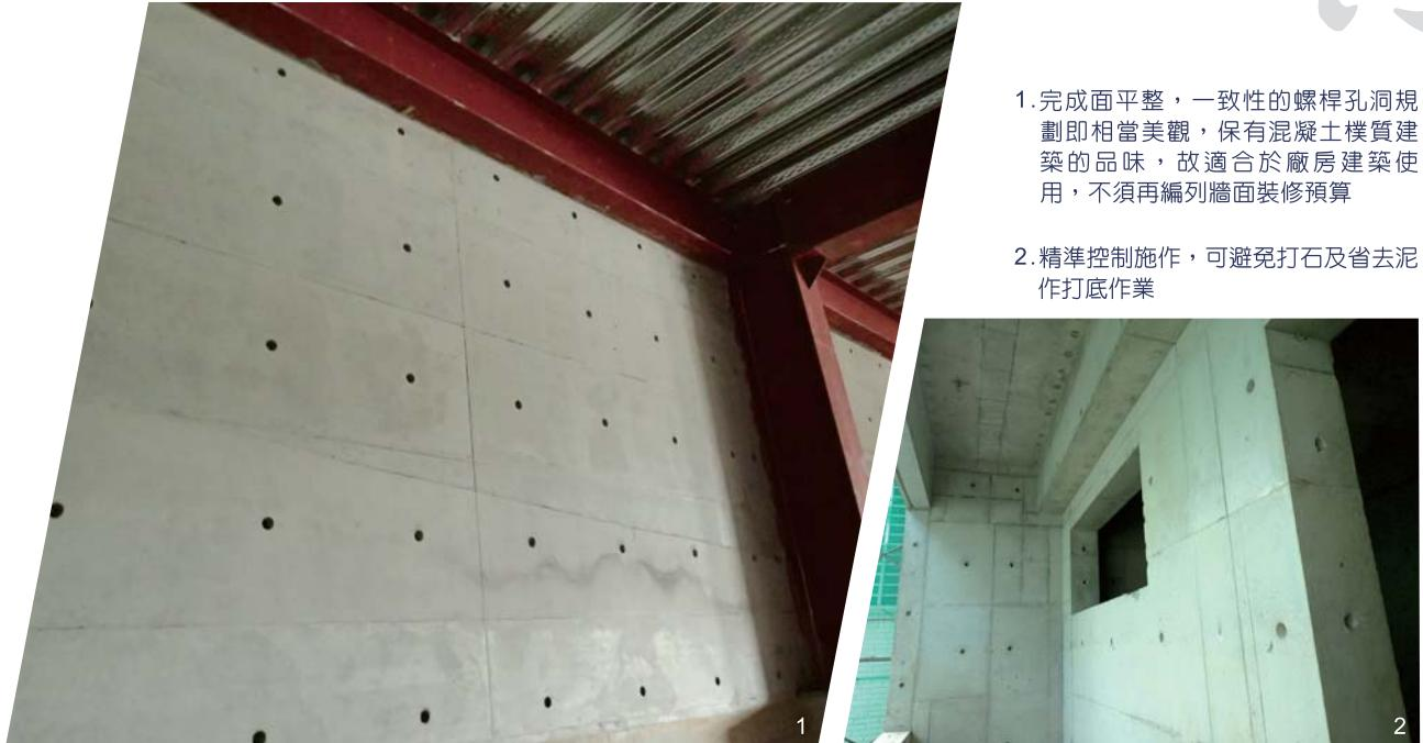
1. 完成面平整，一致性的螺桿孔洞規劃即相當美觀，保有混凝土樸質建築的品味，故適合於廠房建築使用，不須再編列牆面裝修預算
