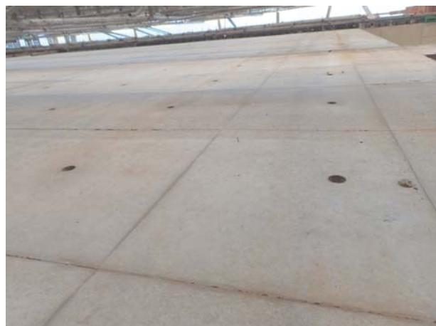
■ 「Alfa Safe系統模板工法」－外牆完成面精準平整，模板交接處簡單研磨批土、免泥作
