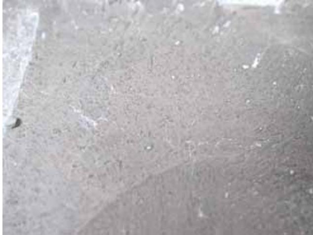
■ 混凝土內部水泥水化熱高，容易產生裂縫，必須適量添加爐石與飛灰，以降低乾縮裂縫產生
