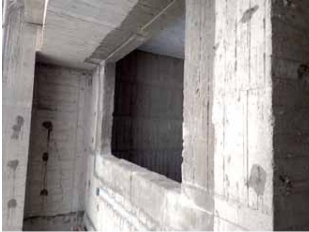
■ 混凝土內部水泥的水化熱相當高，澆置後必須藉著灑水降溫養護，以降低乾縮裂縫產生
