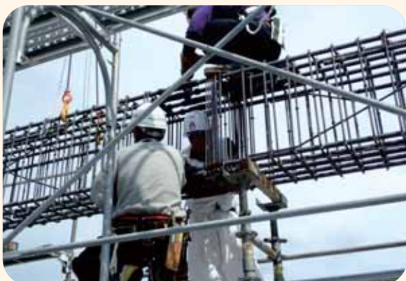
■ 預組梁之對接鎖固 - TTK 預組工法。
