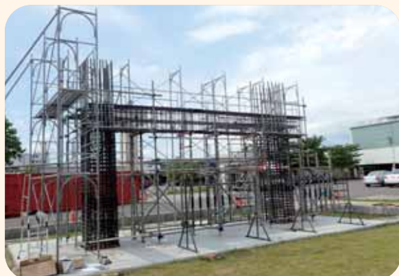
■ 預組梁柱架構吊裝鎖接完成 - TTK。
