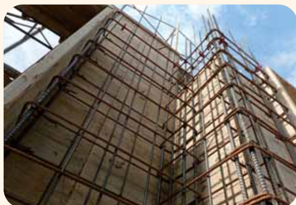
■ 轉角及端部封閉圍束，防裂、防漏水及抗震韌性更加有效提升 - Alfa Safe 耐震系統工法。
