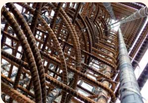
■ 鋼筋一體化配件有效提升房屋結構整體耐震力 - Alfa Safe 耐震系統工法。
