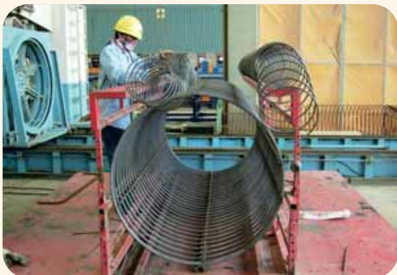
■ 預鑄柱之鋼筋專利工法預組中 - 潤弘精密。
