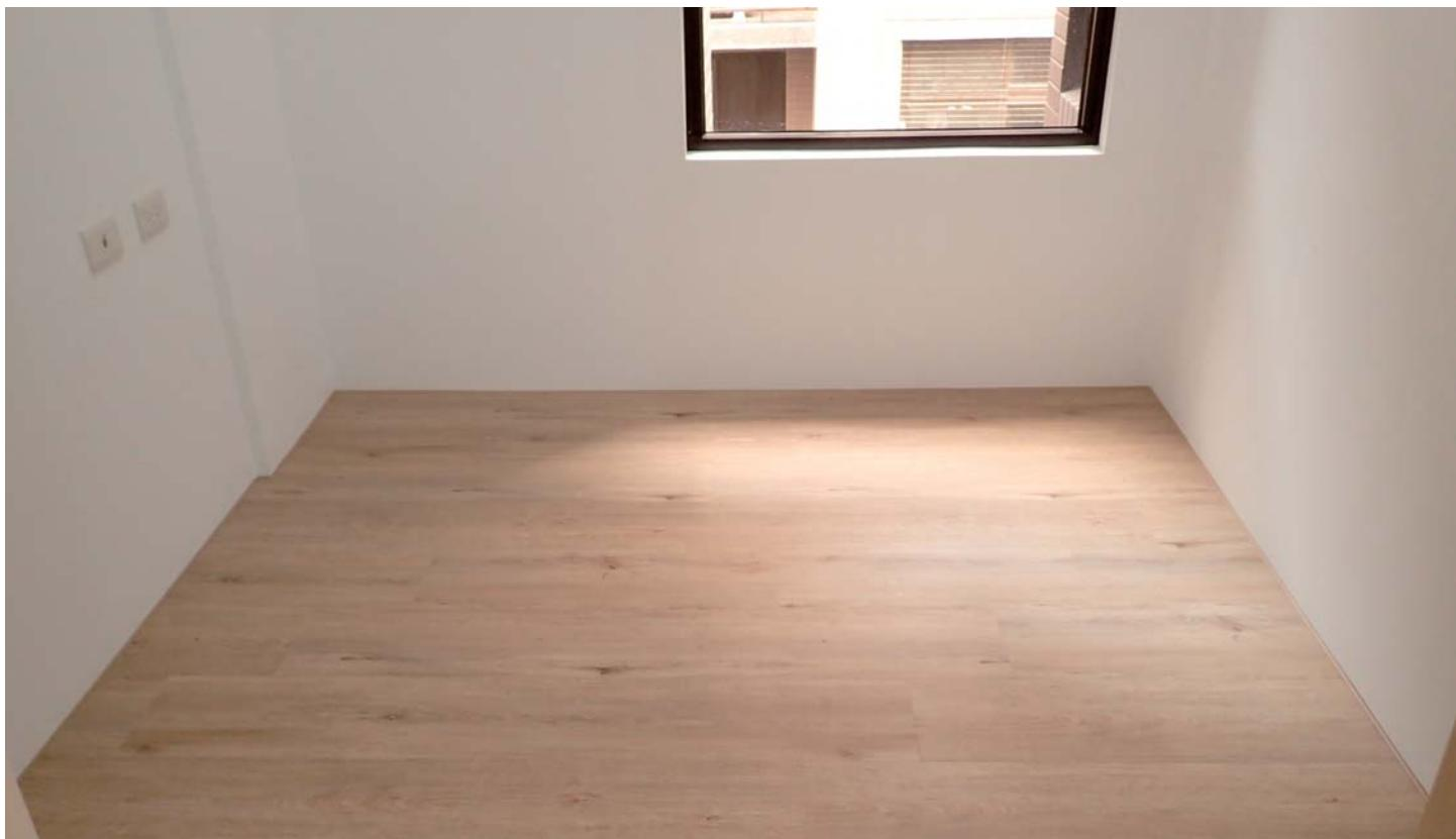
■ 使用符合法規的隔音耐磨木地板鋪設亦可有效阻隔聲音。（圖由中麗建設提供）
