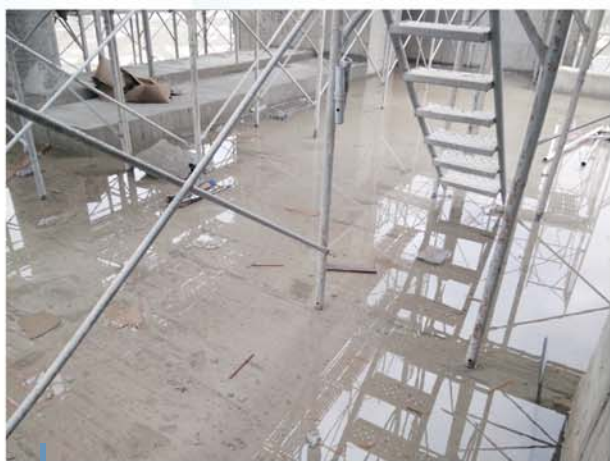
屋頂至少應做3天以上全面試水之檢測，確認全面不漏水後再進行地坪裝修面材的鋪貼。
