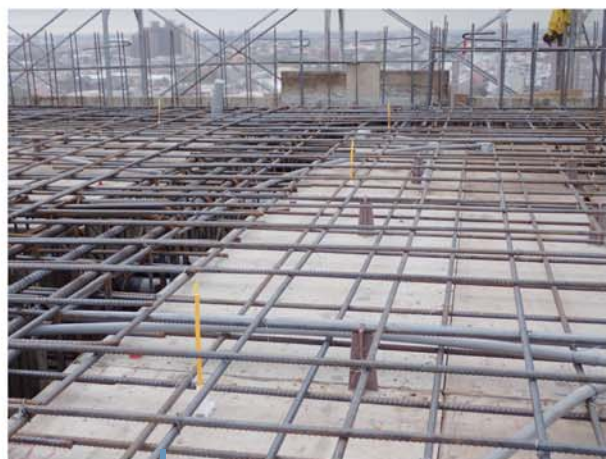
洩水坡度要確實以免積水。
