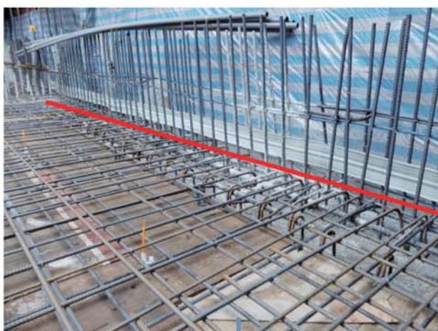
於牆底施作止水帶在牆體內，以能阻絕地下水滲入。
