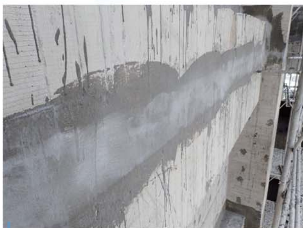
樓層接縫防水施作(與立窗前防水施作一併查驗紀錄)。
