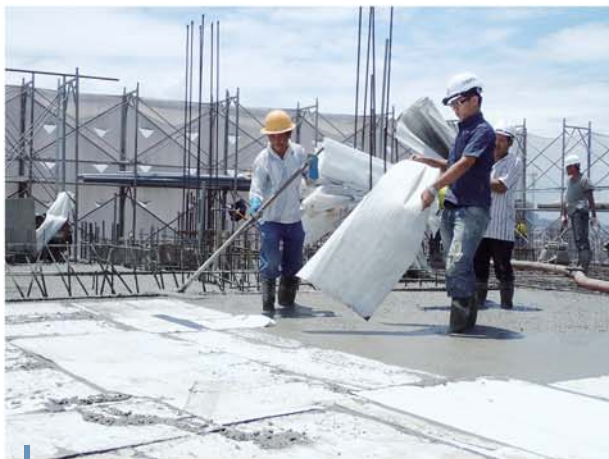
混凝土澆置時特別加強人力搗實及澆置後覆蓋PP版的養護。
