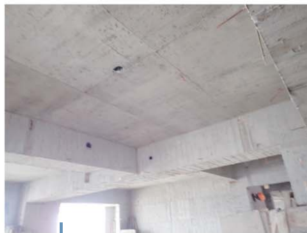
試水時檢測梁版底部有無漏水。
