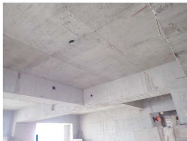
試水時檢測梁版底部有無漏水。
