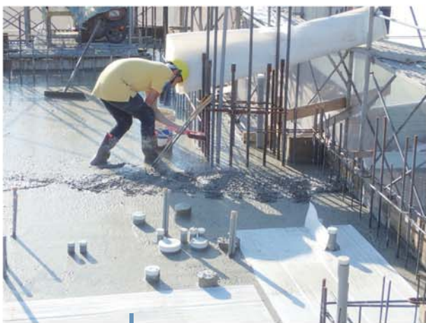
柱筋沾黏混凝土清洗。
