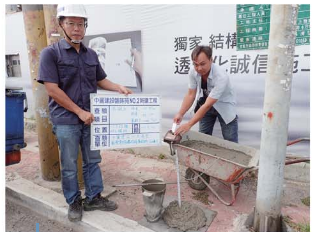
施工現場混凝土強度、坍度、氯離子查驗。
