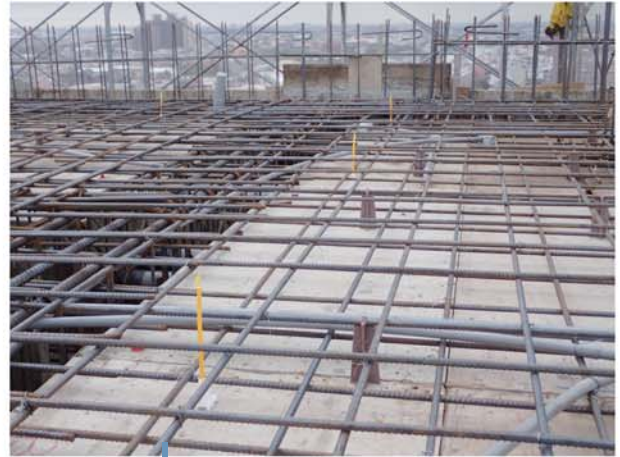
洩水坡度要確實以免積水。
