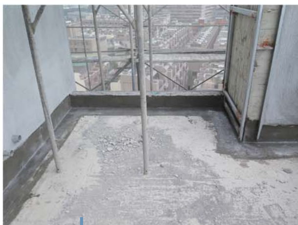
女兒牆L角隅斷水施作。
