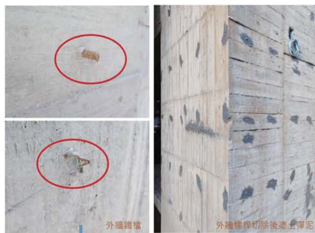
結構體外牆螺桿鐵擋防水。
