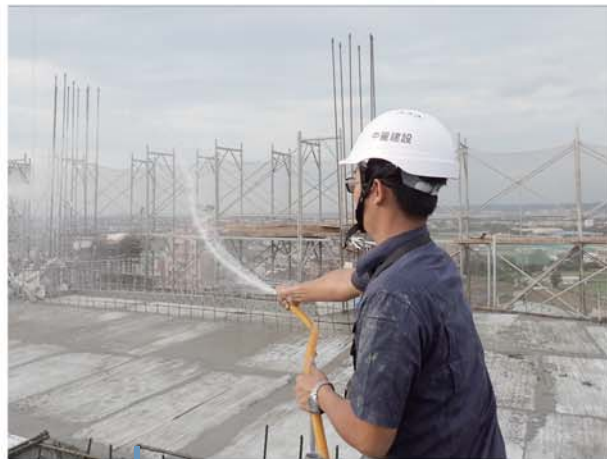
隔天PP版拆除後灑水養護。
